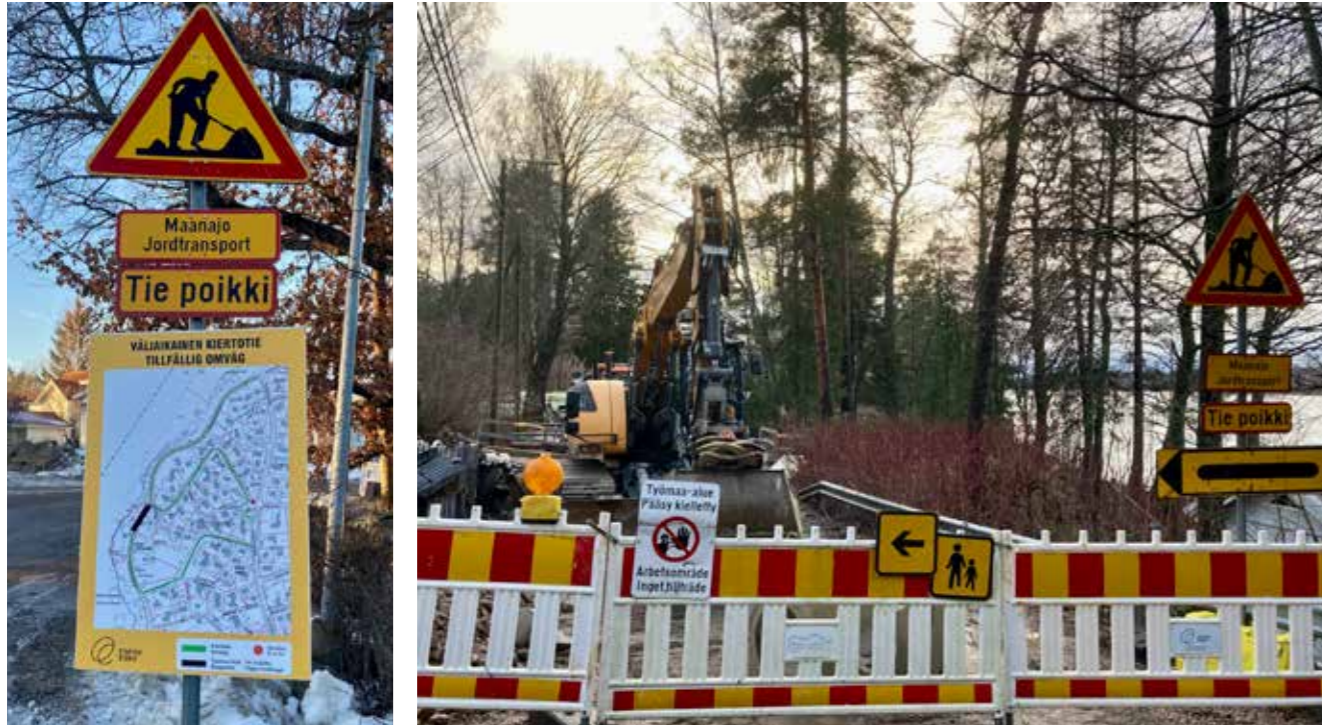
Tietyöt hulevesien osalta jatkuvat Pitkäjärvenranta-tiellä. Kuvat: Elina Airaksinen
