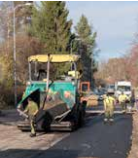
Kannen kuva: Asfalttityöt Tammipääntiellä, Pekka Puomio
