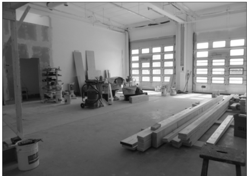
Pitkäjärven VPK:n uudessa hallissa tullaan käsittelemään pelastustöissä likaantuneet varusteet.
