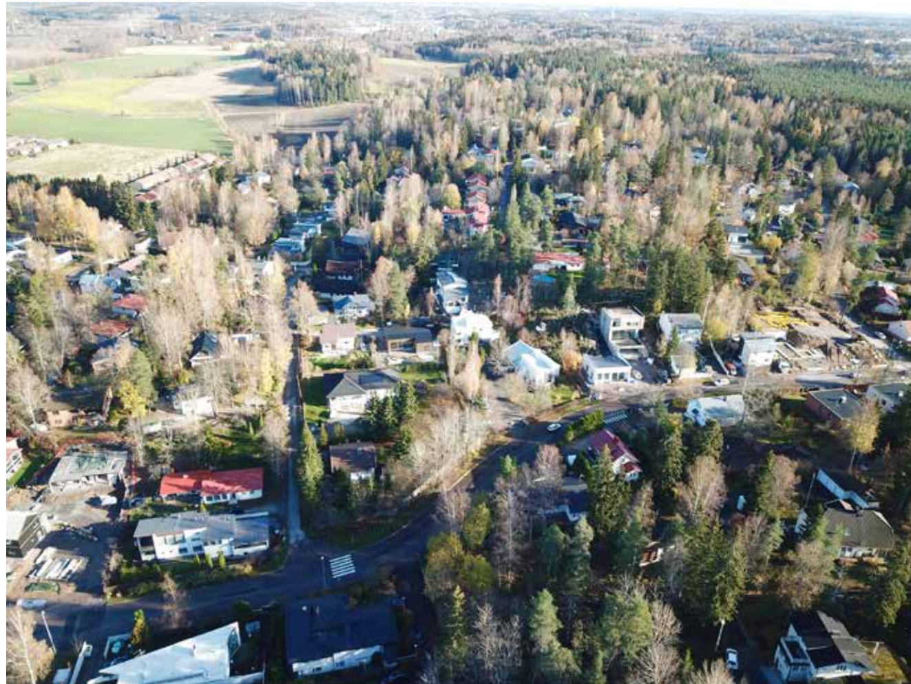
Tammipääntiellä rakennetaan paljon uutta, näkymä ilmasta käsin.
