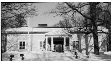
Kantatilan päärakennus nykyisessä asussaan.
